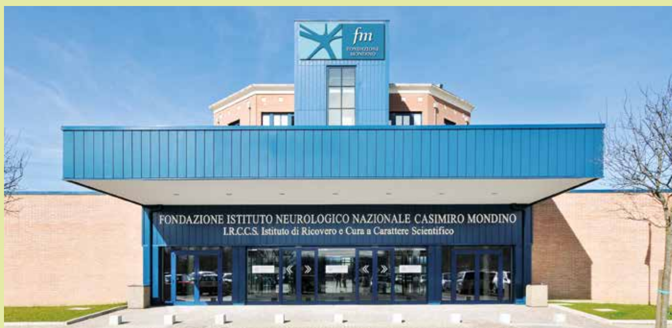
Vista dell'ingresso dell'IRCCS Fondazione Mondino di Pavia.
